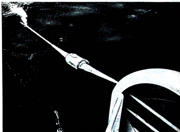
ICECAN Verstärker während der Legung
